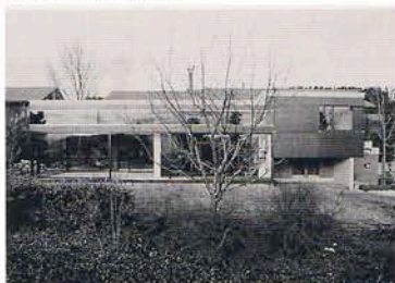
«Metamorphose»: Anbau Haus Maurer | Maurer House Annex | Zuzwil, 1989–93
