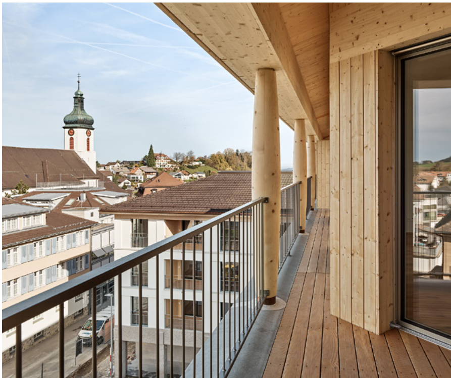
Die Wohnungen unter dem Dach des höchsten Gebäudes am Platz, der Bank, profitieren von weiten Ausblicken aus der Holzloggia.
