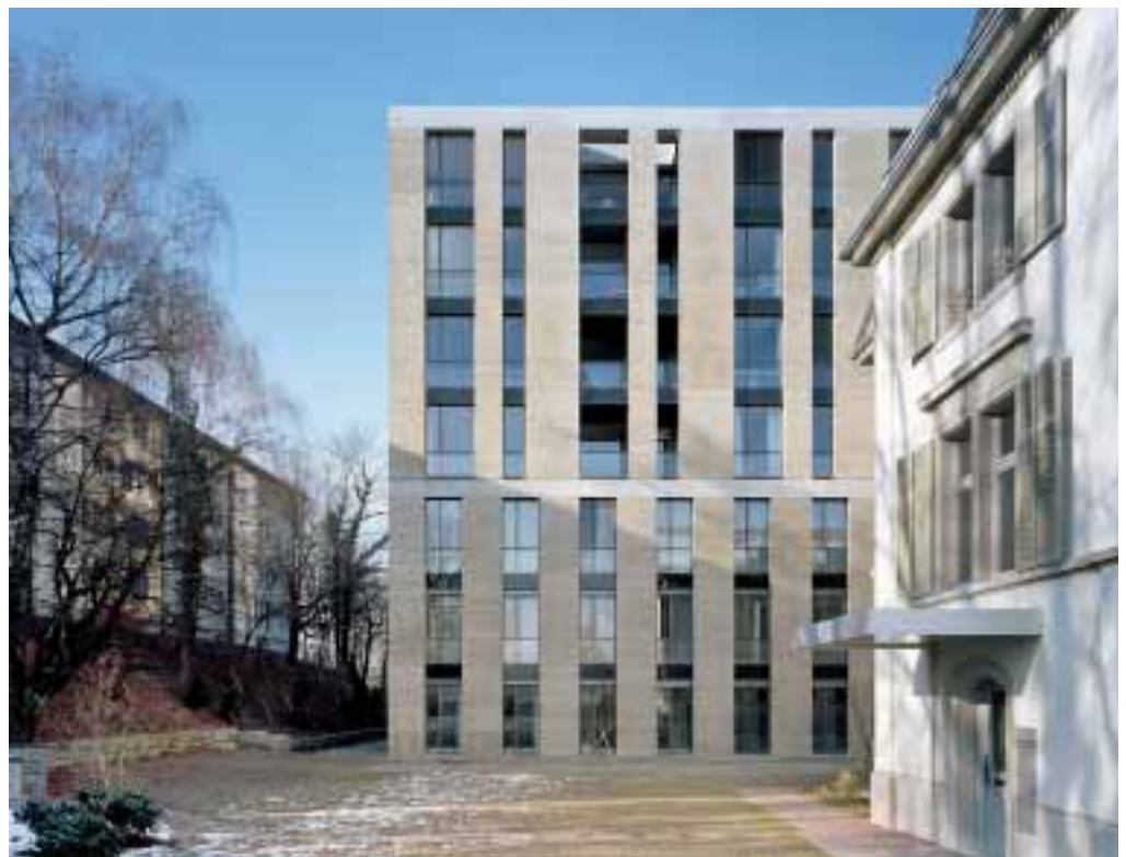
Wohngebäude Malzturm, rechts das Braumeisterhaus
